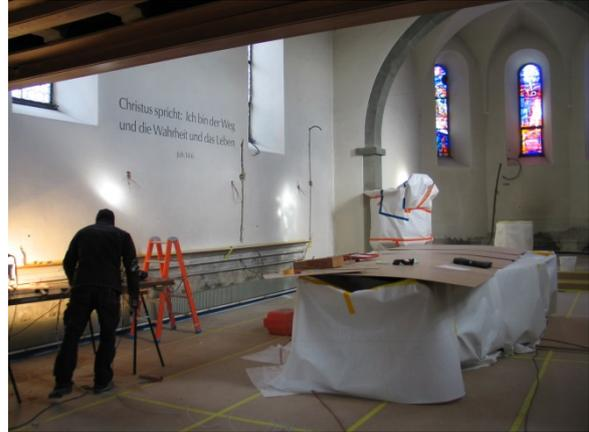
Der nun denkmalgerechte mineralische Farbanstrich garantiert eine bessere Regulierung der Luftfeuchtigkeit, da er atmungsaktiv ist und mit dem Mauerwerk zusammen die Feuchtigkeit zum Teil aufnehmen kann.
